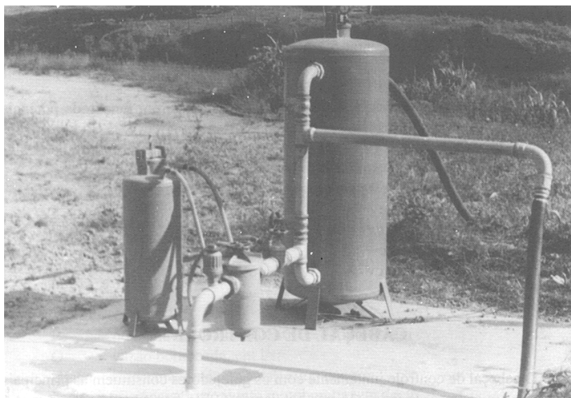
Figura 3 – Vista parcial de um cabeçal de controle.
